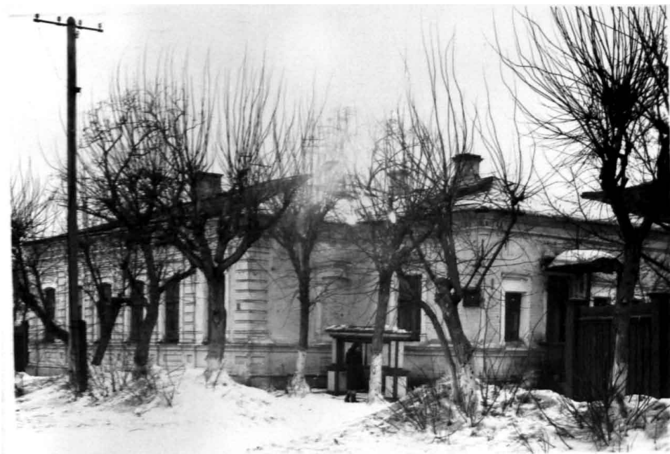
Внешний вид здания библиотеки. Абонемент. Ул. Октябрьская, 5. 1949 г.
